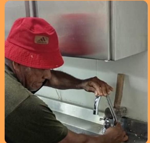
CAMBIO DE MEZCLADOR DEL LAVAPLATOS
